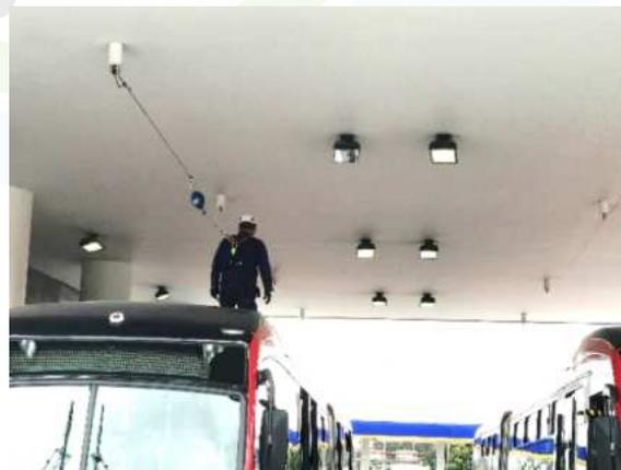
Estos dispositivos se instalan en líneas de vida horizontales tipo Overhead por medio de poleas o carros deslizadores y Sirve para realizar actividades de mantenimiento de vehículos, almacenamiento de mercancías en bodegas
