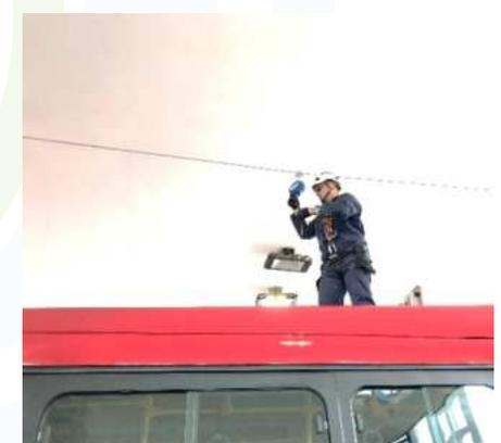
Permiten realizar un mantenimiento seguro en la parte superior de los vehículos, son fabricadas en cables de acero y cuentan con absorbedores de impacto que protegen al trabajador de lesiones al momento de una caída.
