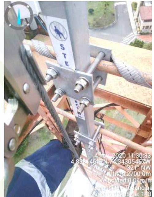
Fabricadas con poste superior de 1.50 metros con cable de acero galvanizado de 3/8" super gx 1x7 alma de acero.
